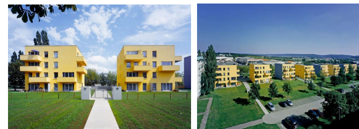
Рисунок 2 – Здание «Haus 07» после завершения реконструкции
